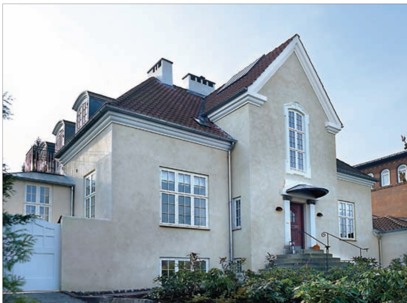
Dette hus er udvendigt isoleret med Isopore isoleringssystem. En særlig diffusionsåbenhed eliminerer problemer med ophobet fugt mellem isolering og mur.
